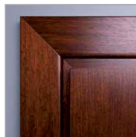
spojení obložkových lišt pod úhlem 45°
