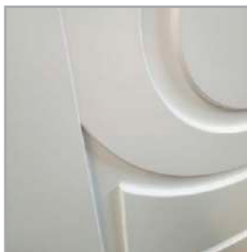
frézování na povrchu křídla
